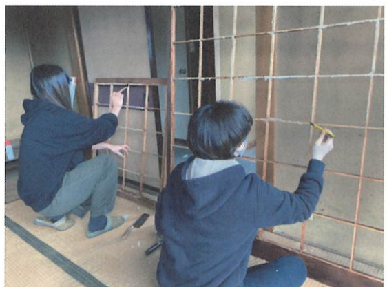
写真2 空き家改修の様子（2021年4月）
