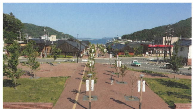
写真 女川駅前付近の現況
